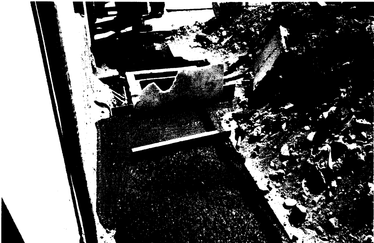
FOTO 14: TRABAJOS DE VACEADO DE LA REPOSICION DE CONCRETO EN LOSA CON UNA f'c = 210 \text{ kg/cm}^2
