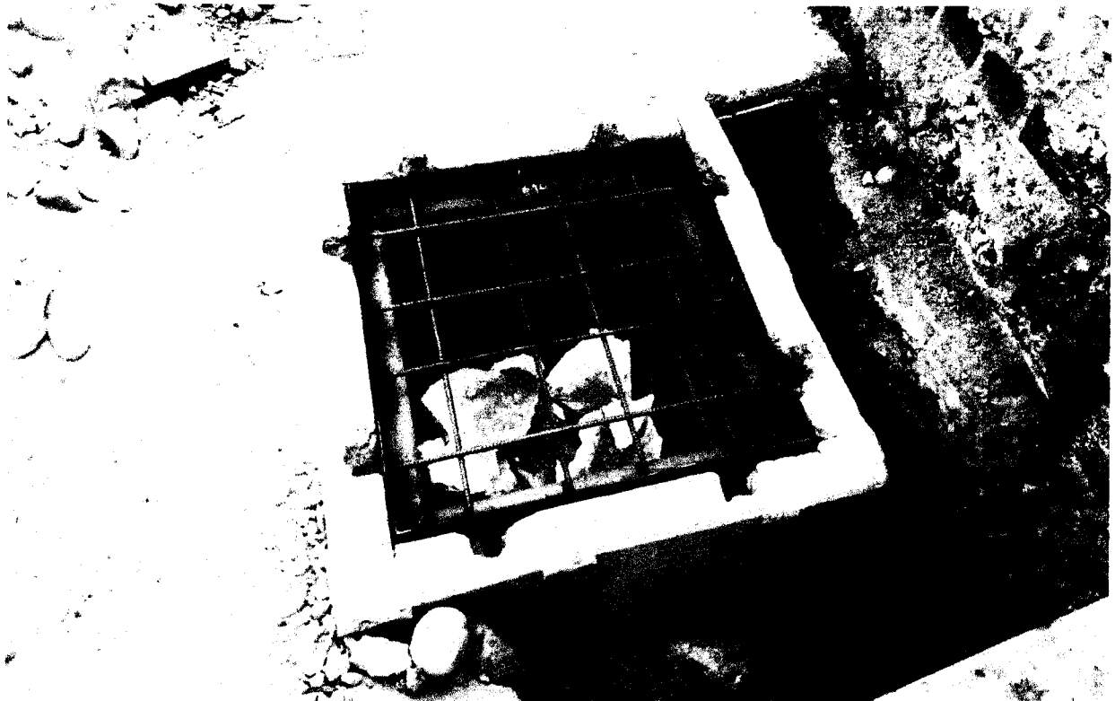
FOTO 22: INSTALACION DE TAPAS PARA LAS BUZONETAS ELECTRICAS
