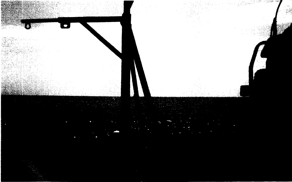
FOTO 03: TRABAJOS DE COLOCACION DE PESCANTE
