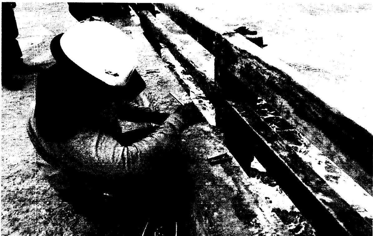
FOTO 16: TRABAJOS PRELIMINARES PARA LA INSTALACION DE TUBERIA CONDUIT IMC 25 mm
