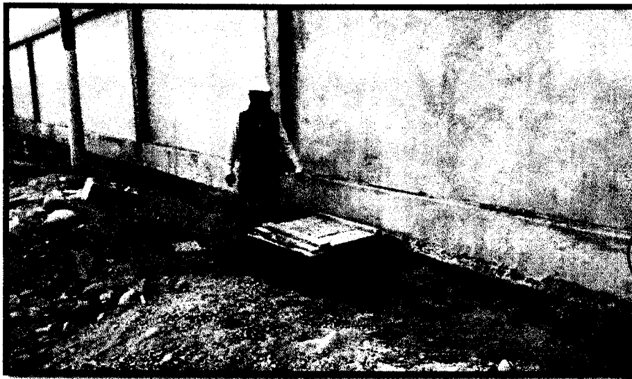
FOTO N°26: SE OBSERVA AL ASISTENTE DE SEGURIDAD REVISANDO LAS TAPAS DE MADERA PROVISIONALES DE LA BUZONETA PARA PREVENIR ACCIDENTE.
