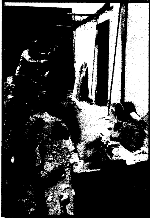
FOTO N°21: SE APRECIA EL TRANSPORTADO DE ARENA A LA ZANJA PARA LA COLOCACION DE TUBERIAS ELECTRICAS. USO DE EPP's.
