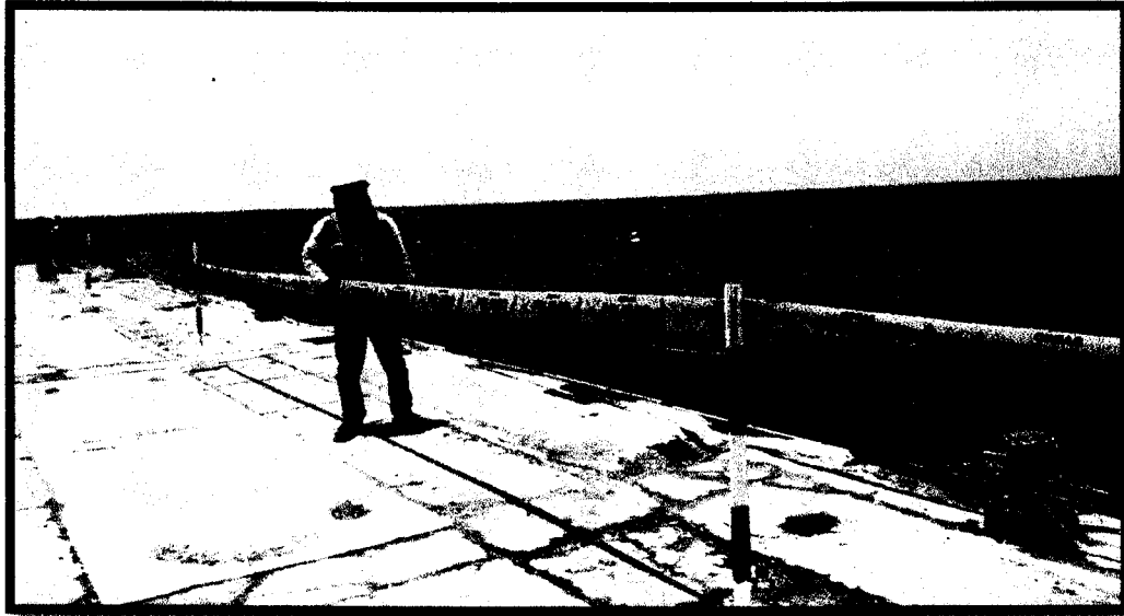
FOTO N°13: SE VISUALIZA AL ASISTENTE DE SEGURIDAD Y EL ENCINTADO DEL AREA DE TRABAJO ANTES DE COMENZAR LA LABOR EN LA LOSA DEL MUELLE.
